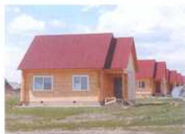
В крае реализуется масштабный проект малоэтажного домостроения
